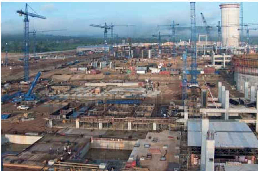
Zementanlagen-Großbaustelle in Nigeria
